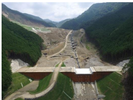
熊野地区砂防堰堤(完成)
