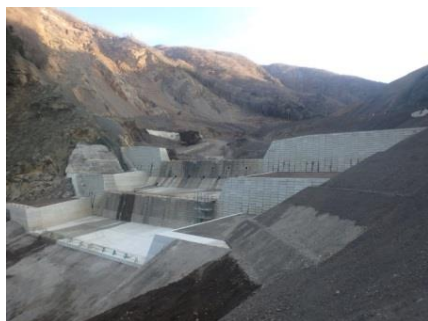
赤谷地区2号砂防堰堤(完成)
