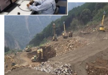
最大14台の無人化重機が稼働
