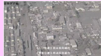
平成28年10月噴火住宅地の降灰状況
