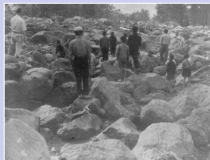
旧白水村(現南阿蘇村)地先 (出典:熊本県大水害写真集)
