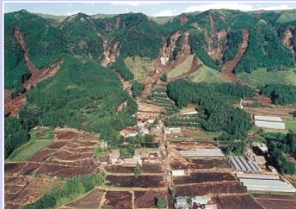
阿蘇カルデラ内壁の崩壊と土石流・流木の氾濫(阿蘇市坂梨地区)
