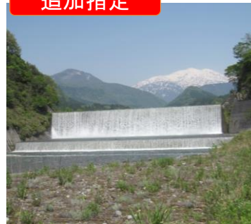
本宮堰堤(昭和11年竣工)
