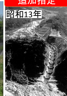
泥谷堰堤(昭和13年竣工)
