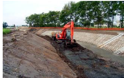
河道の掘削工事
