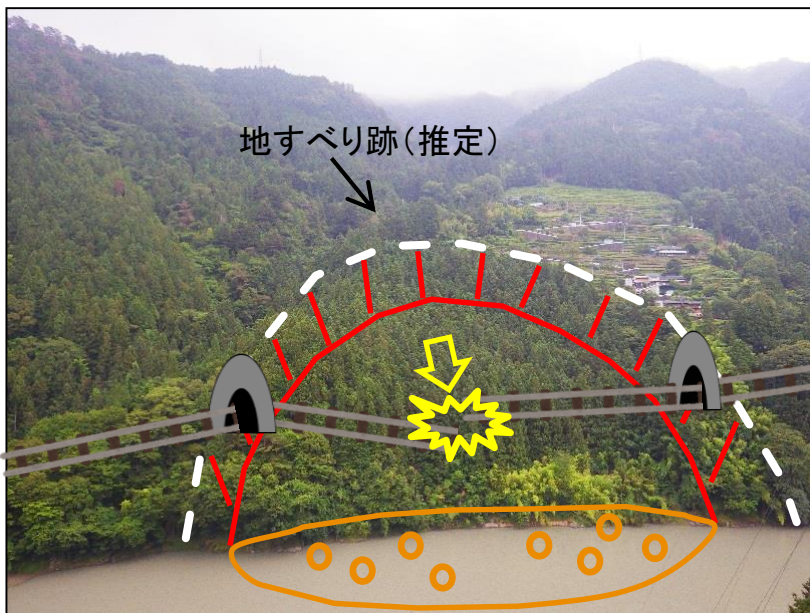
1936年 天龍村での地すべり発生事例 ・鉄道建設時に地すべりが発生し、掘削中のトンネルが閉塞。
