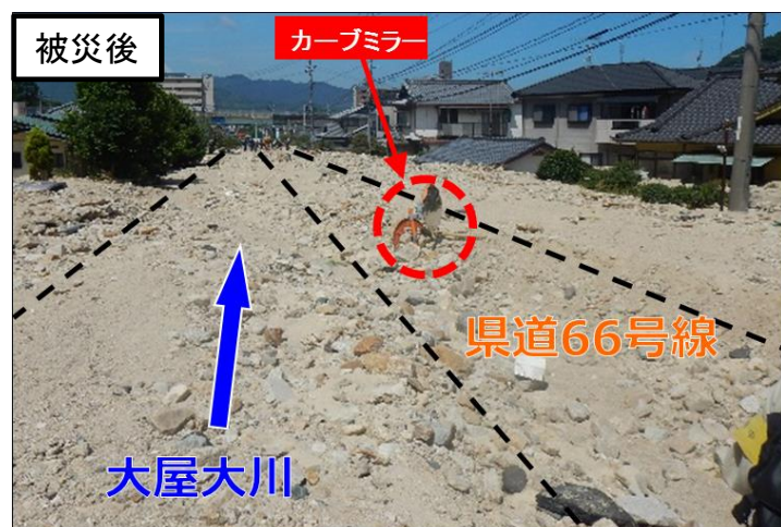
大屋大川(広島県呉市) 県道66号が7/6～11/25(143日間)通行止め
