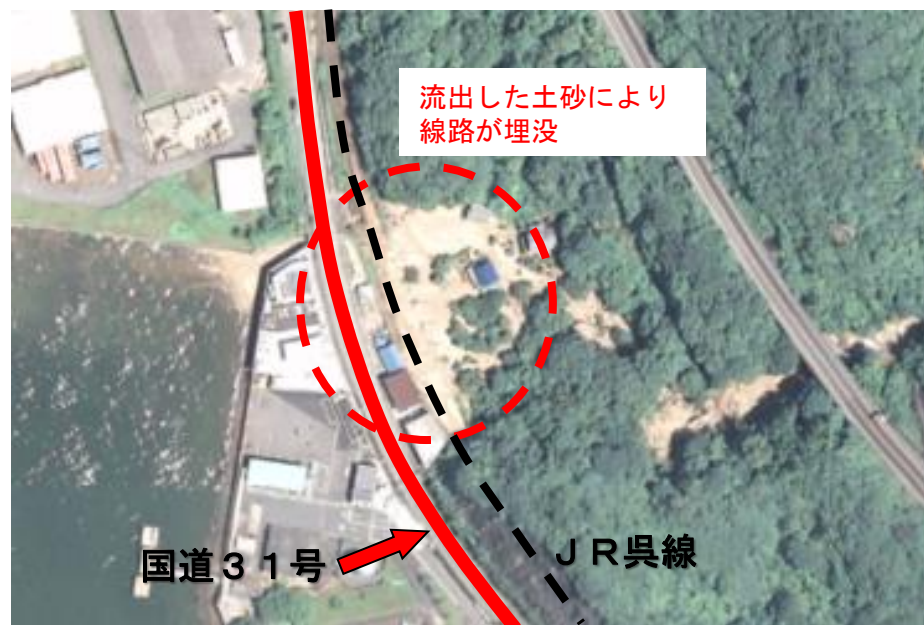
JR呉線、国道31号の被災状況（広島県呉市）
