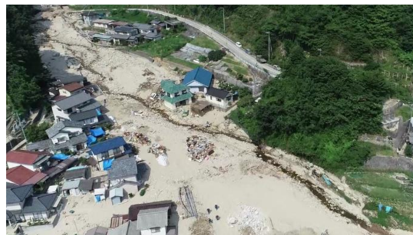
天地川(広島県坂町) 県道278号が7/7～8/31(55日間)通行止め
