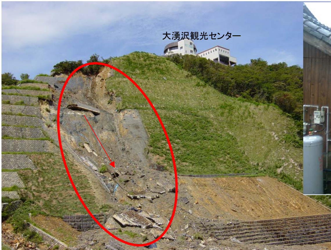
大湧沢で発生した地すべり【神奈川県足柄下郡箱根町】
