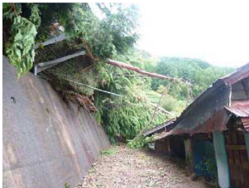
① 宅裏の状況 (一部流出した土砂により埋塞)
