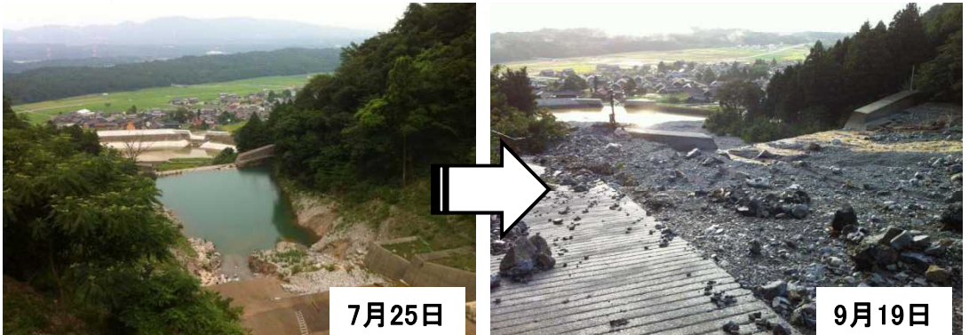
1号堰堤の土石流捕捉状況
