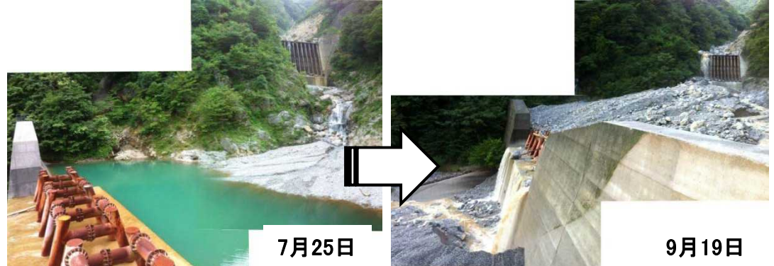
1号堰堤の土石流捕捉状況
