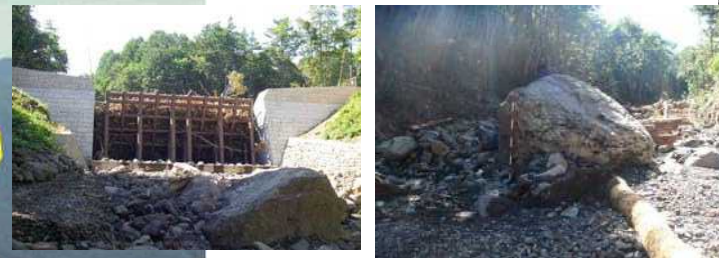
堰堤により捕捉された流木・巨石
