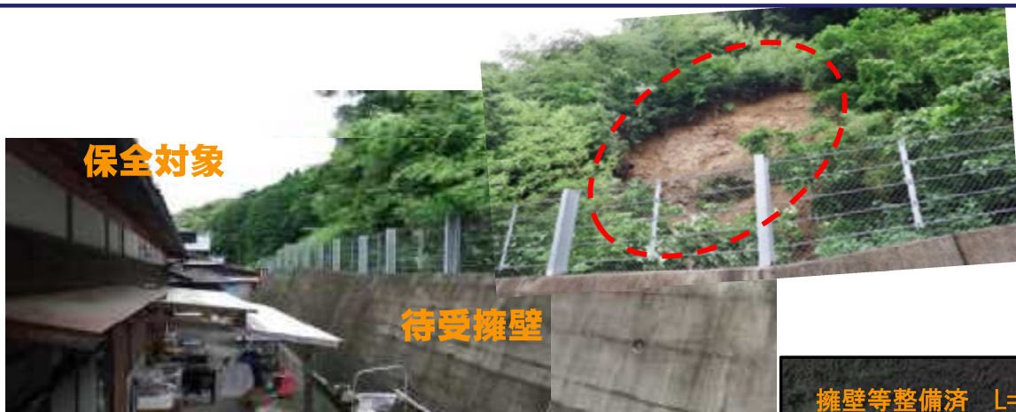
待受擁壁により崩壊土砂から家屋が守られた
