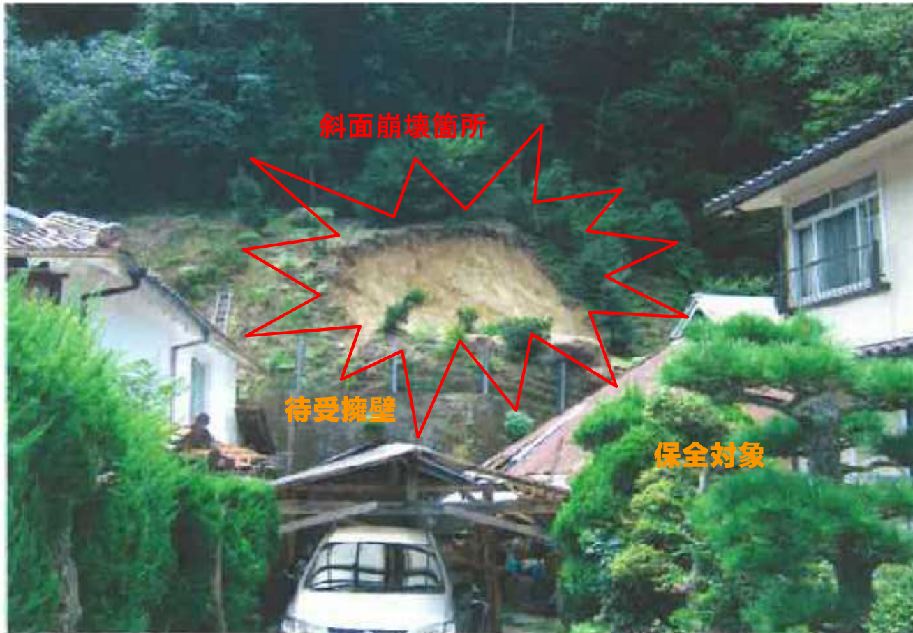
待受擁壁により崩壊土砂から家屋が守られた
