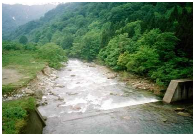
流木捕捉工設置前 (H12 撮影)
