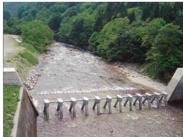
流木捕捉工設置時 (H14)
