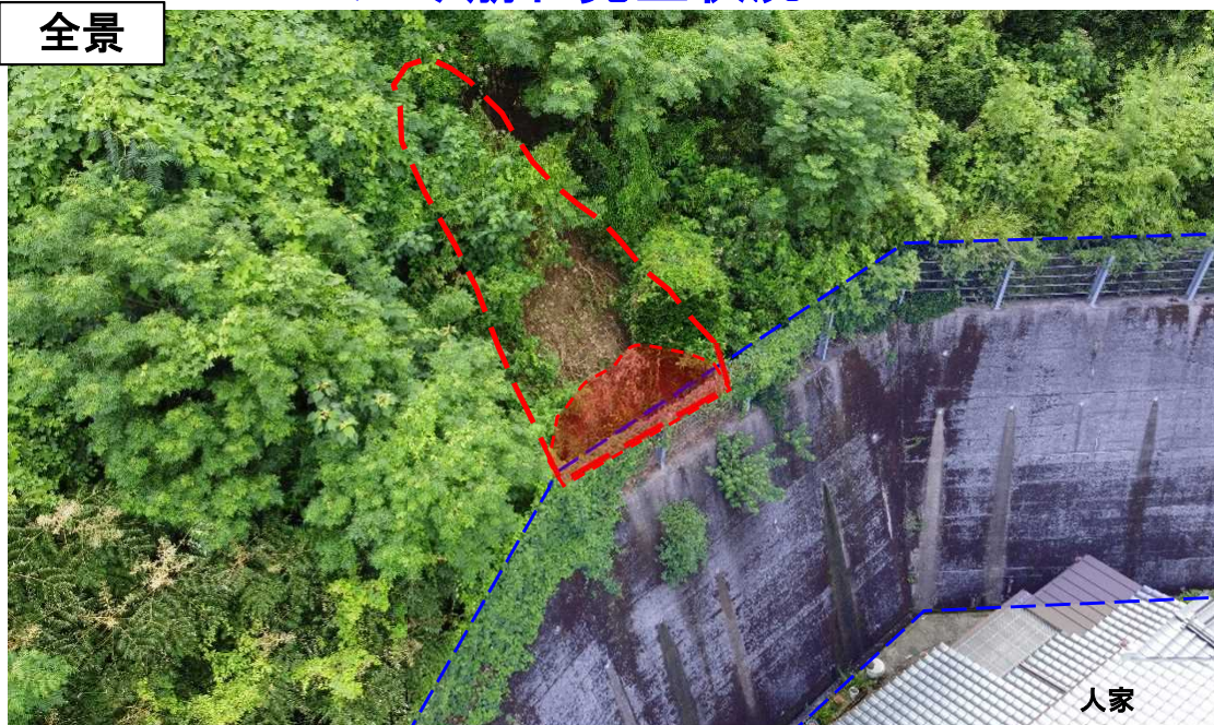
急傾斜地崩壊防止施設 (落石防護柵及び擁壁)
