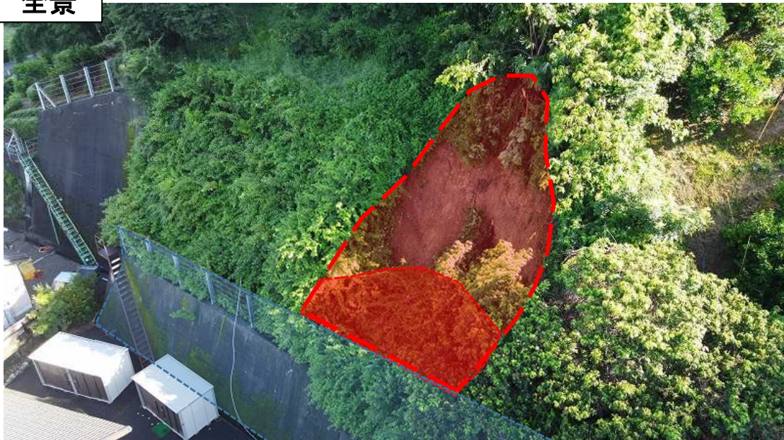
急傾斜地崩壊防止施設 (落石防護柵及び擁壁)
