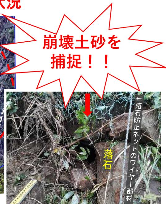
破損しつつも「落石防止ネット (鋼製ネット+ワイヤー部材)」が落石の人家到達を防止した。
