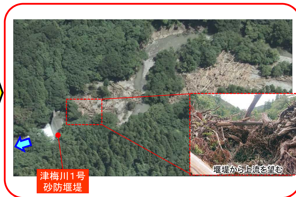
土石流発生後(令和4年8月19日撮影)
