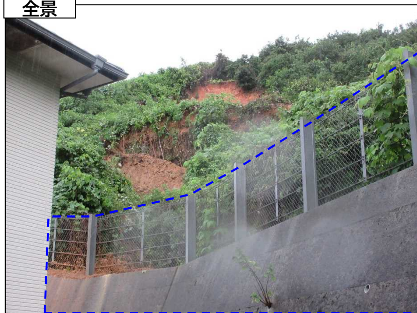
急傾斜地崩壊防止施設 (待受擁壁工)
