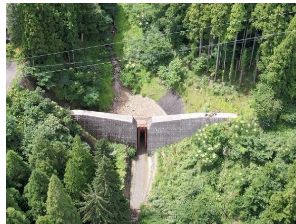
土石流発生直後
