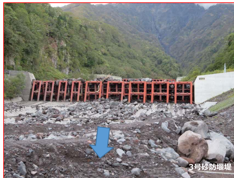
土石流発生後(令和5年9月29日 撮影)
