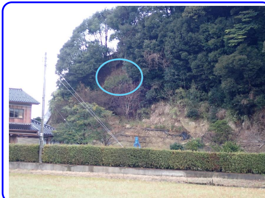
①斜面崩壊発生状況【R6.1.7撮影】 《未対策箇所》
