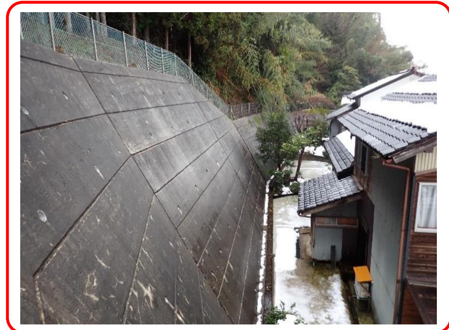
②対策済み斜面 (S57~60年度施工)【R6.1.9撮影】 (擁壁工を施工した人家裏の斜面では崩壊を防止) 《対策済み箇所》
