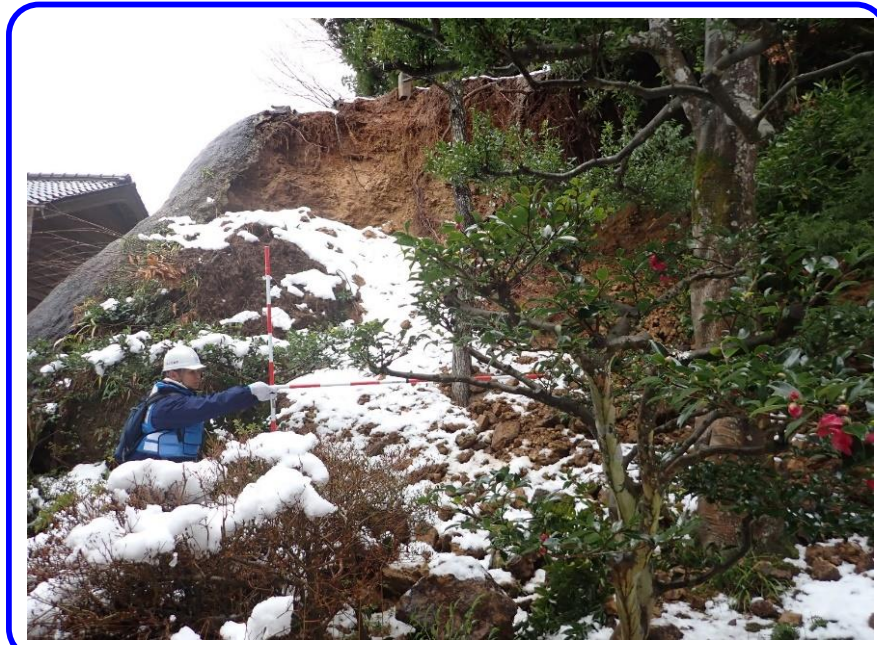
①斜面崩壊発生状況【R6.1.9撮影】 《未対策箇所》
