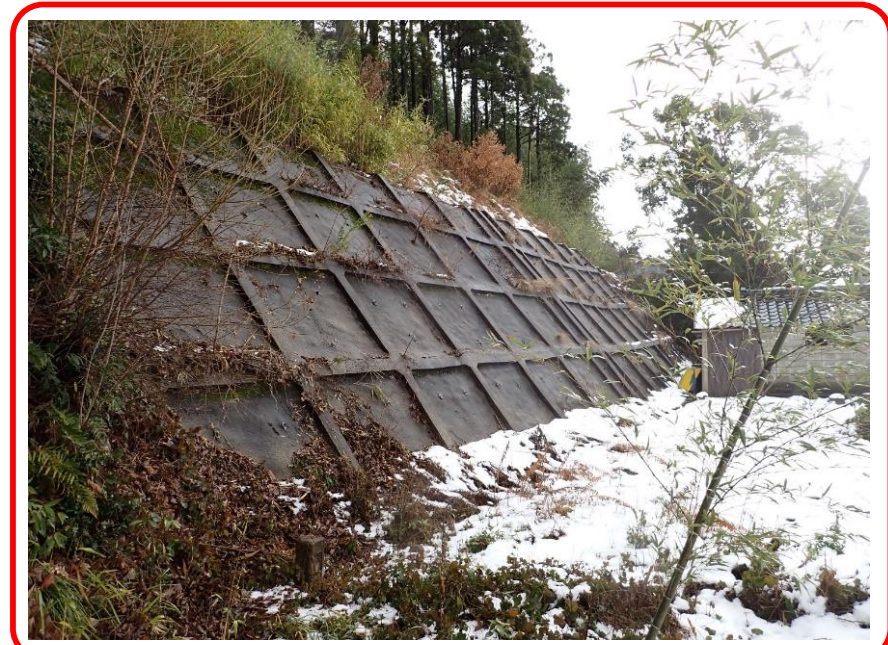
②対策済み斜面 (S62~H4年度施工)【R6.1.9撮影】 (法枠工を施工した人家裏の斜面では崩壊を防止) 《対策済み箇所》
