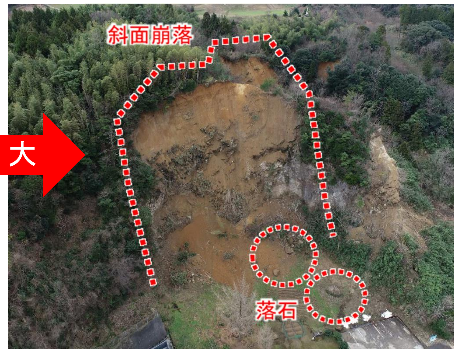
②斜面崩壊発生箇所
