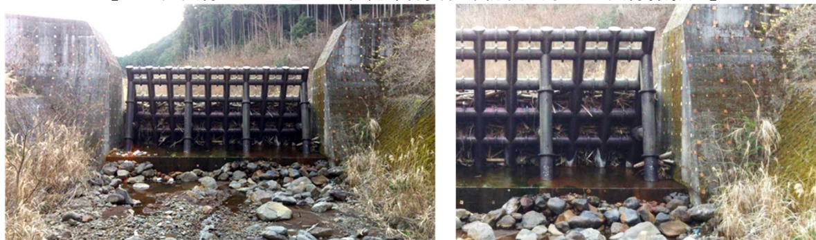
【正立面画像による透過型堰堤部材変状確認例（水平正画像撮影）】
