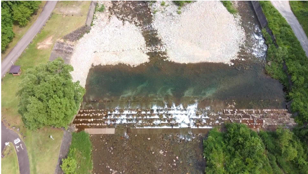
【UAV 点検における溪流保全工撮影(斜め撮影例)】
