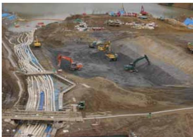
写真 仮排水路工(開水路)施工状況
