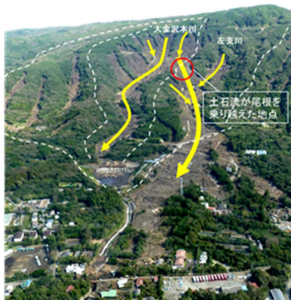
平成25年に伊豆大島で発生した土石流の状況
