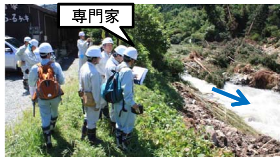
現地合同調査(末端部の状況)
