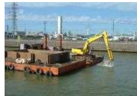
河床掘削 (関川水系保倉川)
