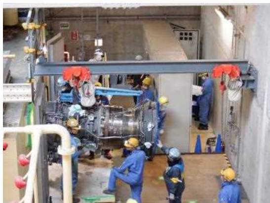
ガスタービン 取り外し
