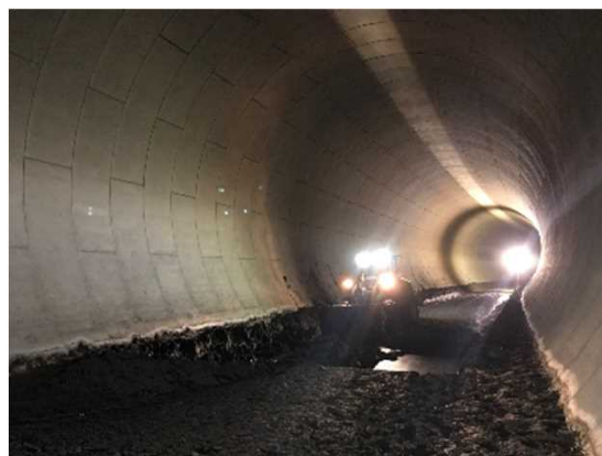
トンネル内の土砂撤去
