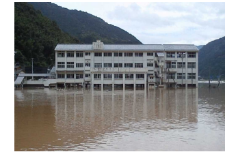
H26. 8 避難所2階の浸水(徳島県)
