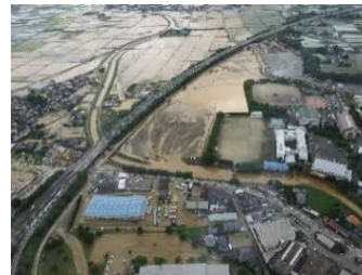
桂川における浸水被害
