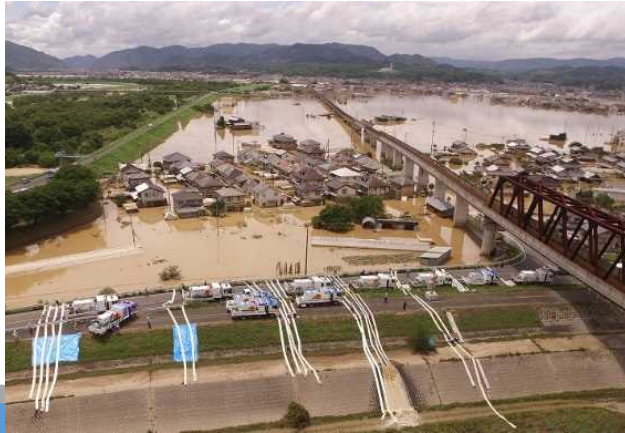
排水ポンプ車による緊急排水
