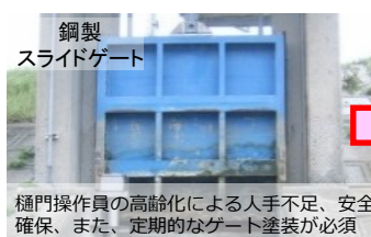
水位変動で開閉する無動力・自動化、また、塗装不要のゲートで延命、コスト減
