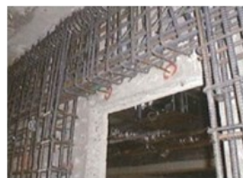
処理場の耐震化（躯体補強）
