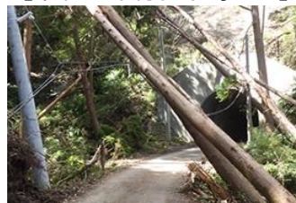
⑥倒木・倒壊の状況 (千葉県鴨川市)
