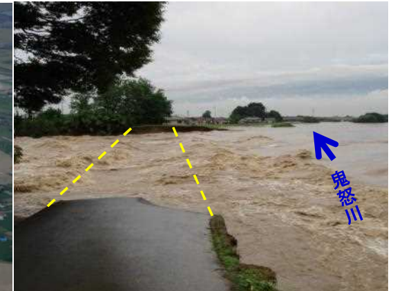
被災状況(拡大写真)
