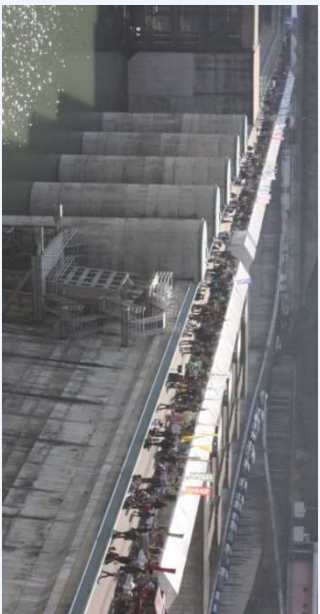
ダム天端での物産展
