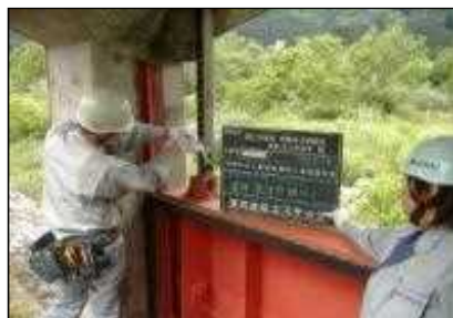
（樋門ゲートの点検）
