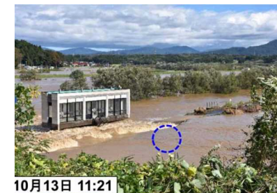
④川表側のり面の崩壊の進行
