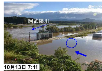
③堤内地側の水位上昇による越水
