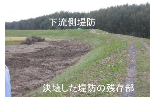
上流側から下流側の堤防を見た状況
