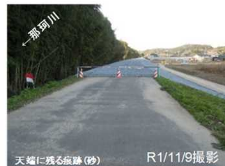
越水に伴い天端に残存する砂
