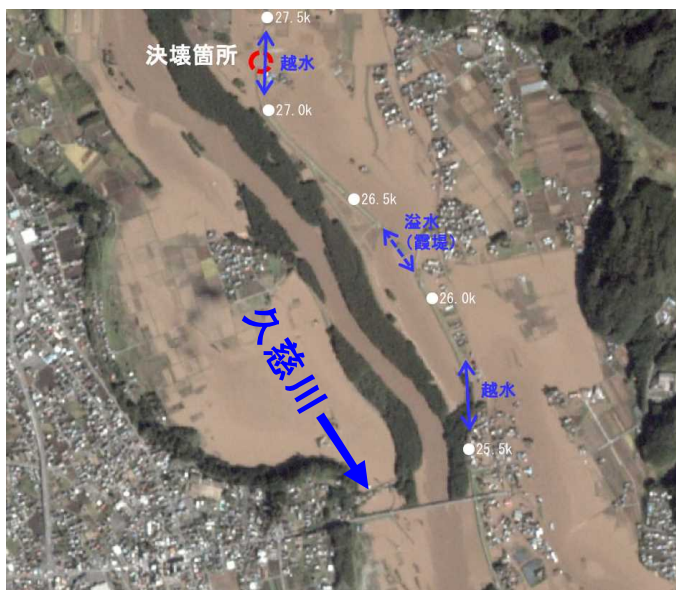
久慈川左岸27.0kの決壊箇所(2019/10/13撮影) (出典:防災科学研究所クライシスレスポンスサイトに加筆)
