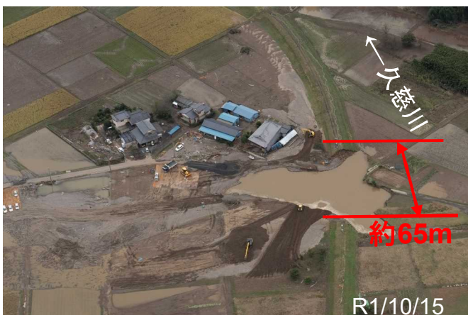
越水箇所斜め写真
