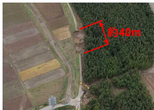
越水箇所斜め写真
