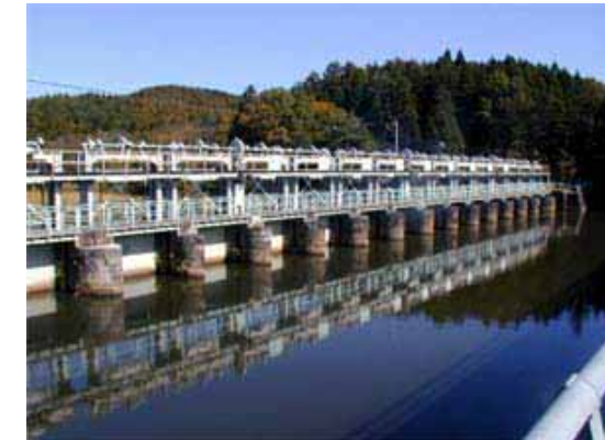
橋脚に見られる大正時代のレンガ造り
