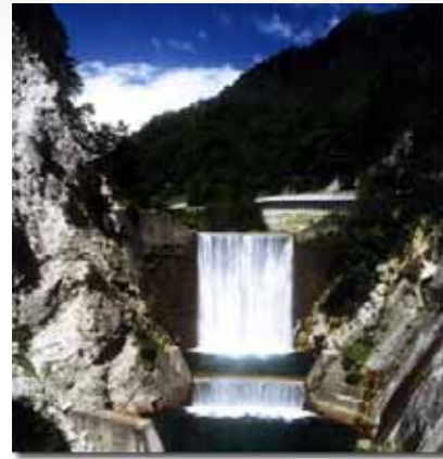
釜ヶ淵堰堤(長野県安曇村)
