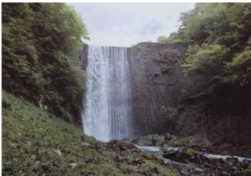
写真 3.2 登録有形文化財の例 方等上流砂防堰堤
