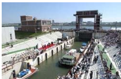
写真 3.2 荒川ロックゲート
