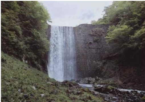
写真 3.3 登録有形文化財の例 方等上流砂防堰堤
