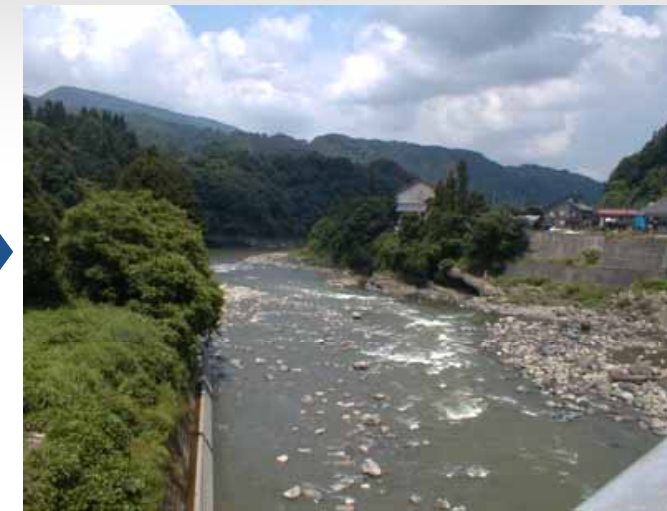
宮野原橋地点 ダム放流量21.4m 3 /s ( H13.7.20撮影)
