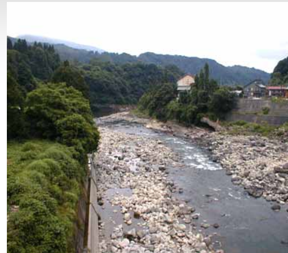
宮野原橋地点 ダム放流量0.3m 3 /s ( H13.7.17撮影)
