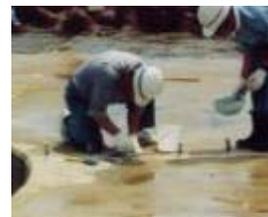
護岸コンクリートのひび割れ補修(注入工)
