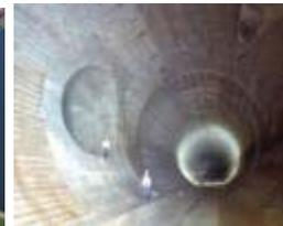
雨水貯留管の整備により、都市の浸水防止
