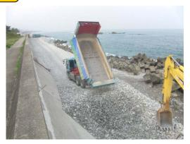
県熊野建設事務所が実施している、国道311号バイパス事業、遊木トンネル(仮称)の掘削ズリを道路 管理者において破砕、粒度調整、運搬を行い、養浜材として活用しています。
