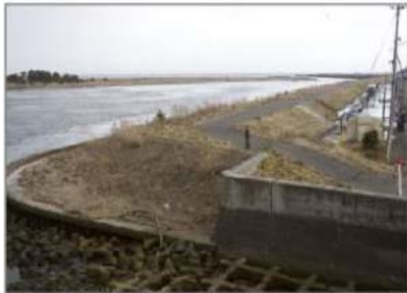
<引き潮の状況> ※ 閑上水門から河口側を望む
