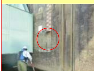
PG4: 量水標欠損
