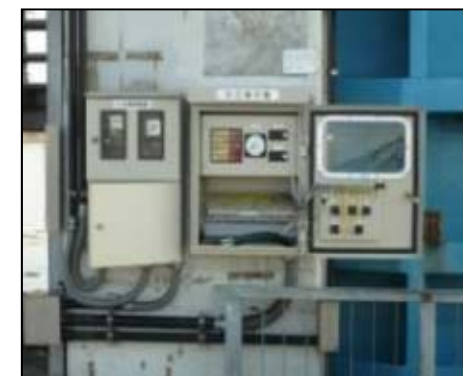
＜手元操作盤の水没＞
