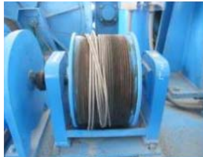
メッセンジャーワイヤードラム乱巻き状況
