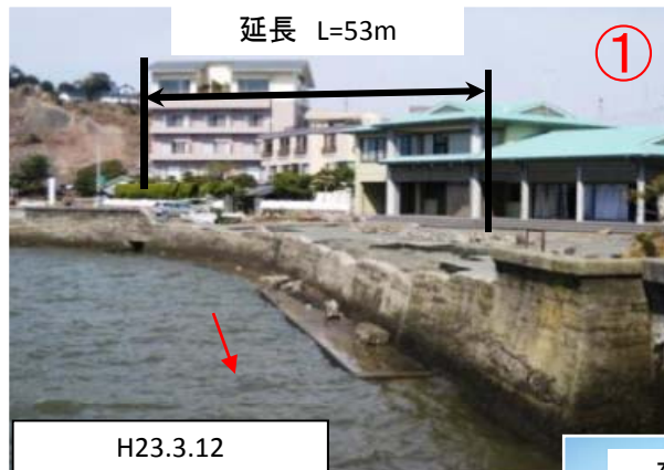
①パラペット堤破損
