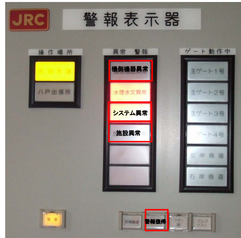
警報表示器 警報復帰ボタンを押すことにより異常をリセット可能
