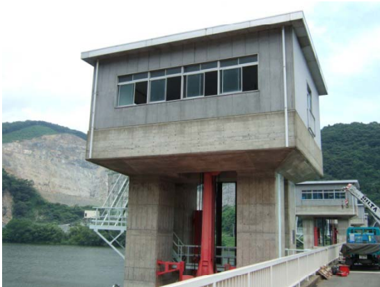
機側操作盤を設置している 堰柱上屋
