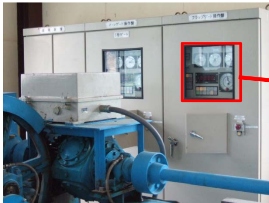
機側操作盤を設置している 堰柱上屋
