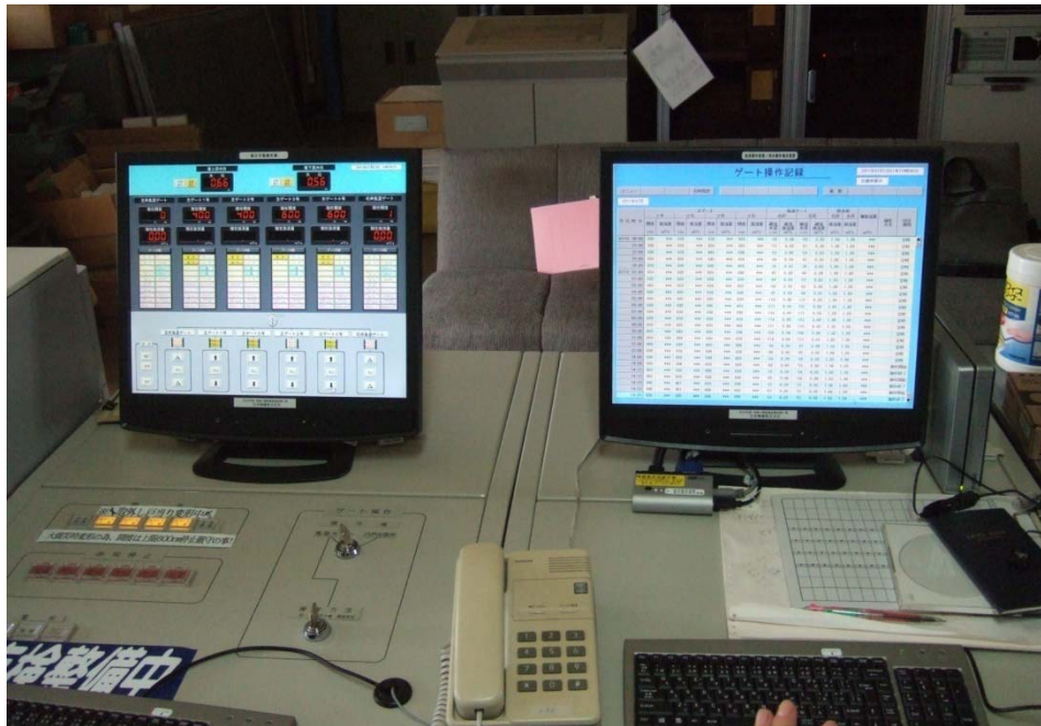
遠方操作盤(左:遠方操作ディスプレイ、右:ゲート操作記録)
