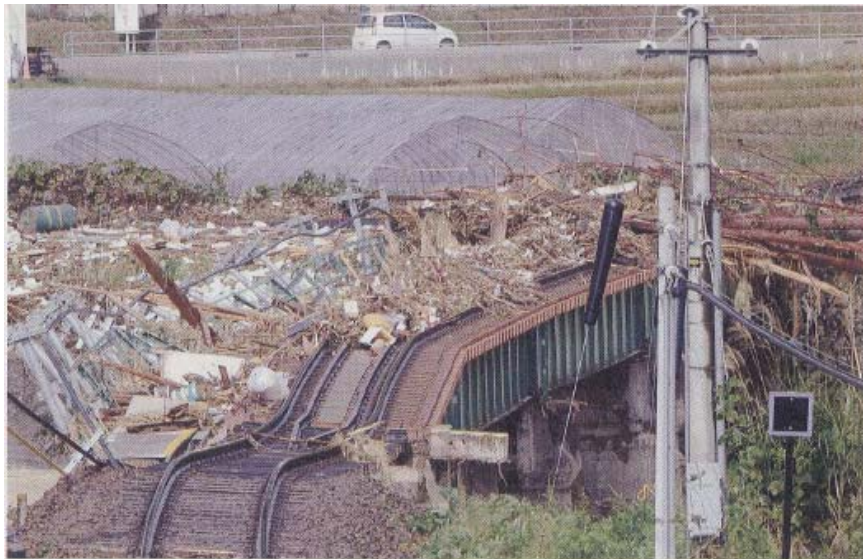
▲大量の流木で崩壊したJR高山線川上川の鉄橋(岐阜県高山市冬頭町) [写真提供/読売新聞社]
