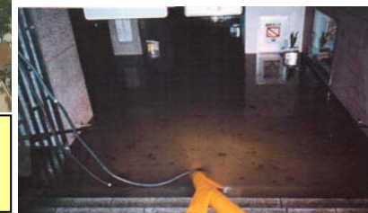
地下鉄野並駅ホーム1番線の浸水状況
