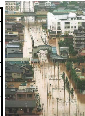
名鉄犬山線下小田井駅及び線路浸水による交通途絶状況
