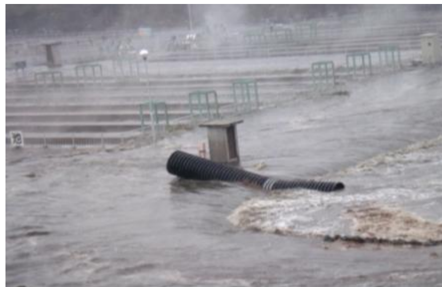
宮城県仙塩浄化センター(多賀城市大代)
