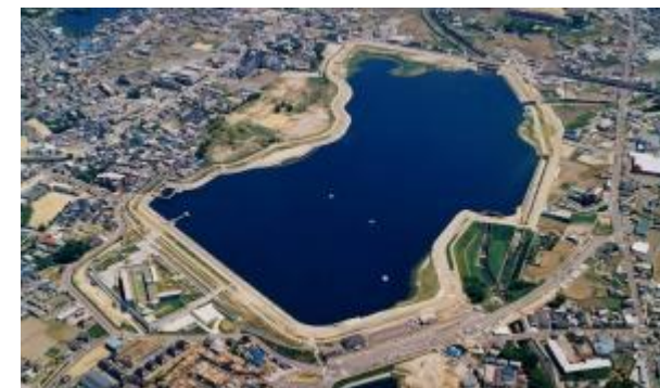
工事後の狭山池
