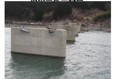
国道45号気仙大橋
