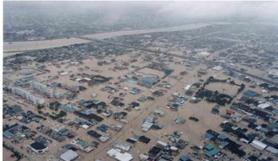
愛知県西枇杷島町の浸水状況
