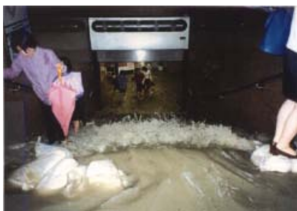
平成 11 年福岡市地下鉄入口の浸水状況 40)
