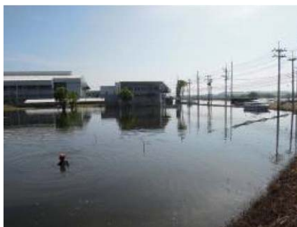
2011 年タイ洪水における工業団地の浸水状況 141)
