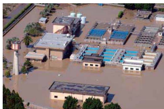
冠水して一面泥水に浸った富吉浄水場 131)
