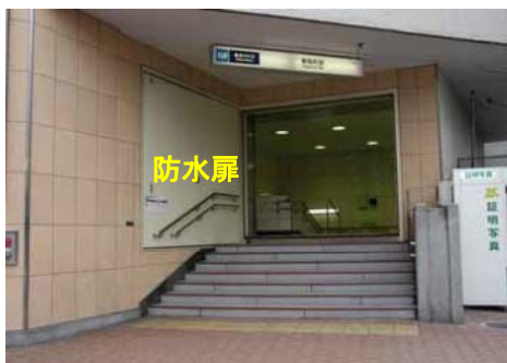
地下鉄の出入口における浸水対策（防水扉）
