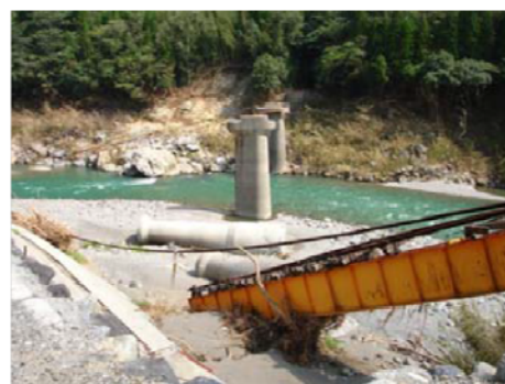
平成17年豪雨による 高千穂線の橋梁流出状況 122)
