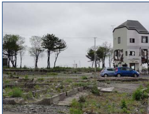
周辺の家がほとんど流され、残った家も復旧の目処がたたない
