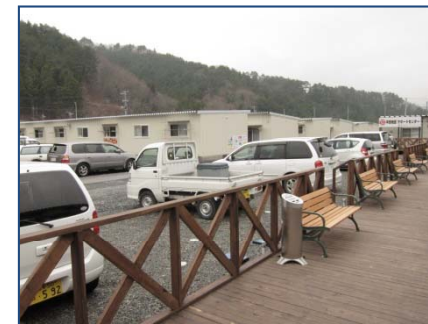
仮設住宅の設営
