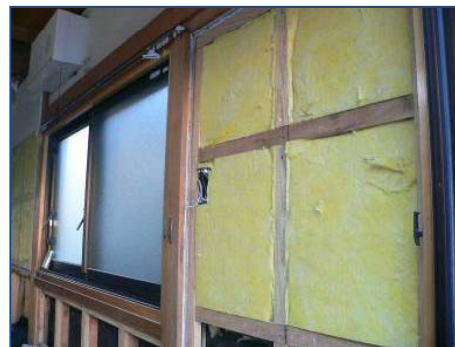
一部が浸かっている内壁を全て交換
