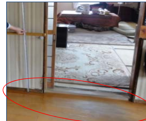
内壁・フローリングは清掃のみで未補修のまま生活している
