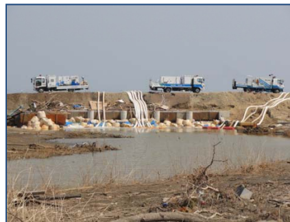
国土交通省の排水ポンプ車による排水作業
