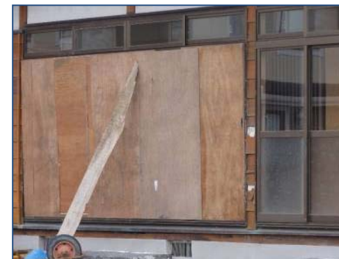
壊れたサッシを板で応急復旧
