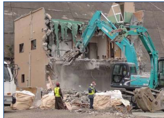
元の場所にすむことをあきらめ、家を解体
