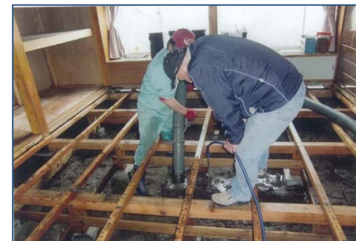
バキュームで吸引して床下の土砂を撤去
