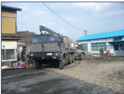
自衛隊によるガレキ撤去作業
