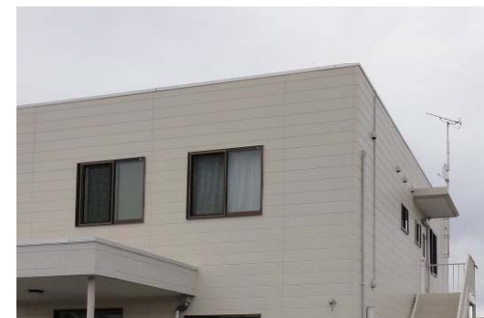
「陸屋根(ろくやね)」とは傾斜のない平面状の屋根
