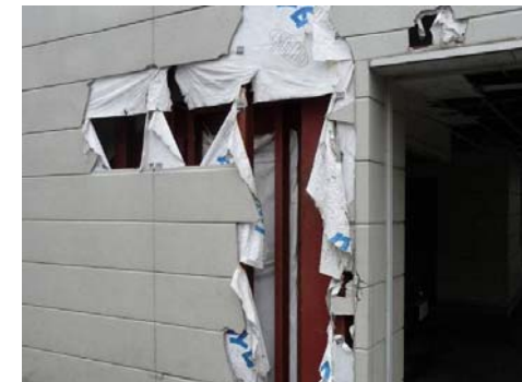
物理的作用でサイディングが剥がれた事例 5
