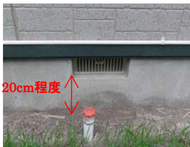
一般的な床下換気孔の例
