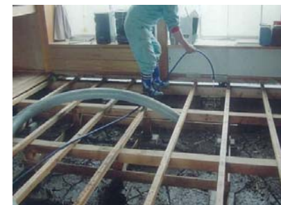
床下の土砂撤去・清掃作業
