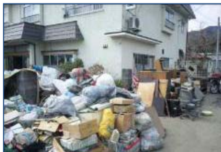
使える家財の分別をするために、解体前に自宅を清掃
