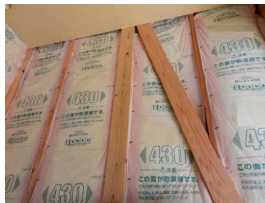
家屋における内壁の断熱材の設置状況
