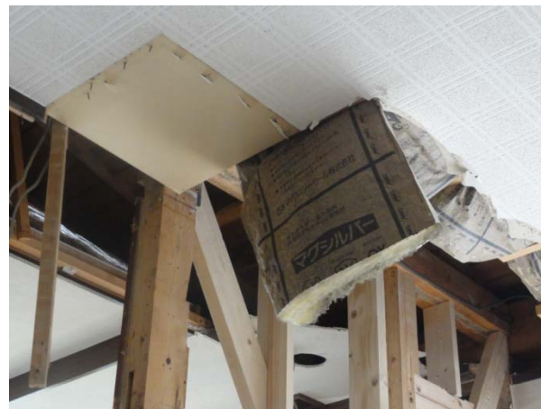
工事の際、天井断熱材も交換している
