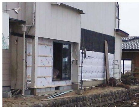
被災した部分の交換(防水シート貼り)
