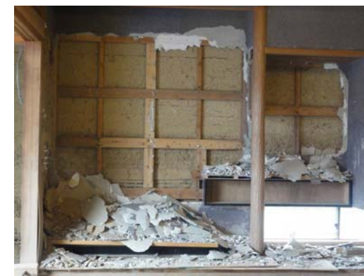
石膏ボードが浸水したため、剥がして乾燥させている
