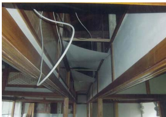
天井工事と併せて、配線工事をしている事例
