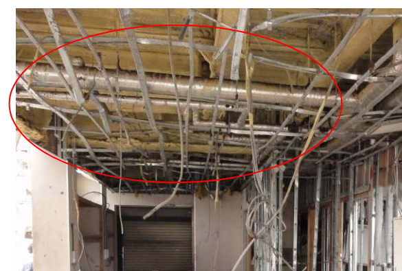
非木造家屋などでは、屋根裏に換気用ダクト等を配し、空調設備も天井にビルトインされている場合がある
