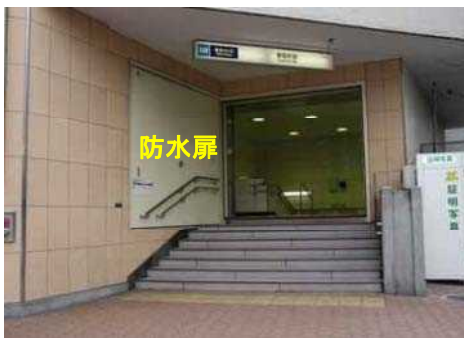
地下鉄の出入口における浸水対策 105) (防水扉)
