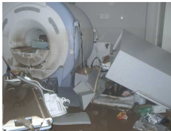
平成17年台風14号による大淀川の氾濫 潤和会記念病院のエックス線室MRIの被災状況 137)
