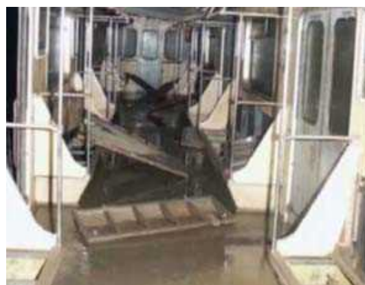
2002 年プラハの洪水により水没した地下鉄車両
