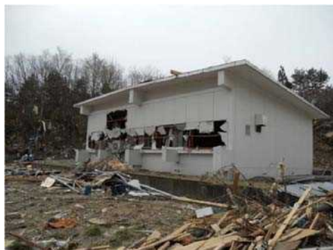
津波により被災した通信設備
