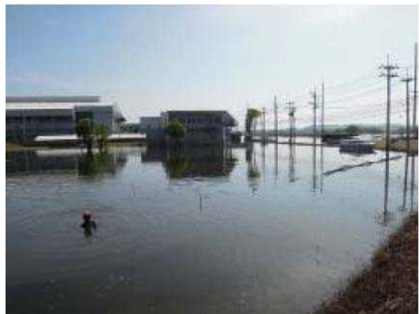
2011 年タイ洪水における工業団地の浸水状況 135)
