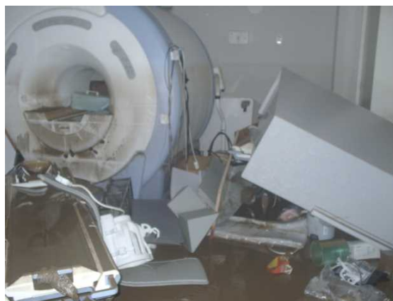
平成 17 年台風 14 号による大淀川の氾濫 潤和会記念病院のエックス線室 MRI の被災状況 16)
