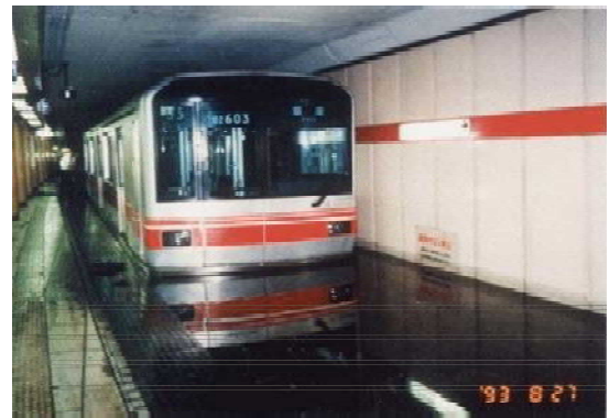
丸ノ内線赤坂見附駅の冠水 東京メトロ（株）提供
