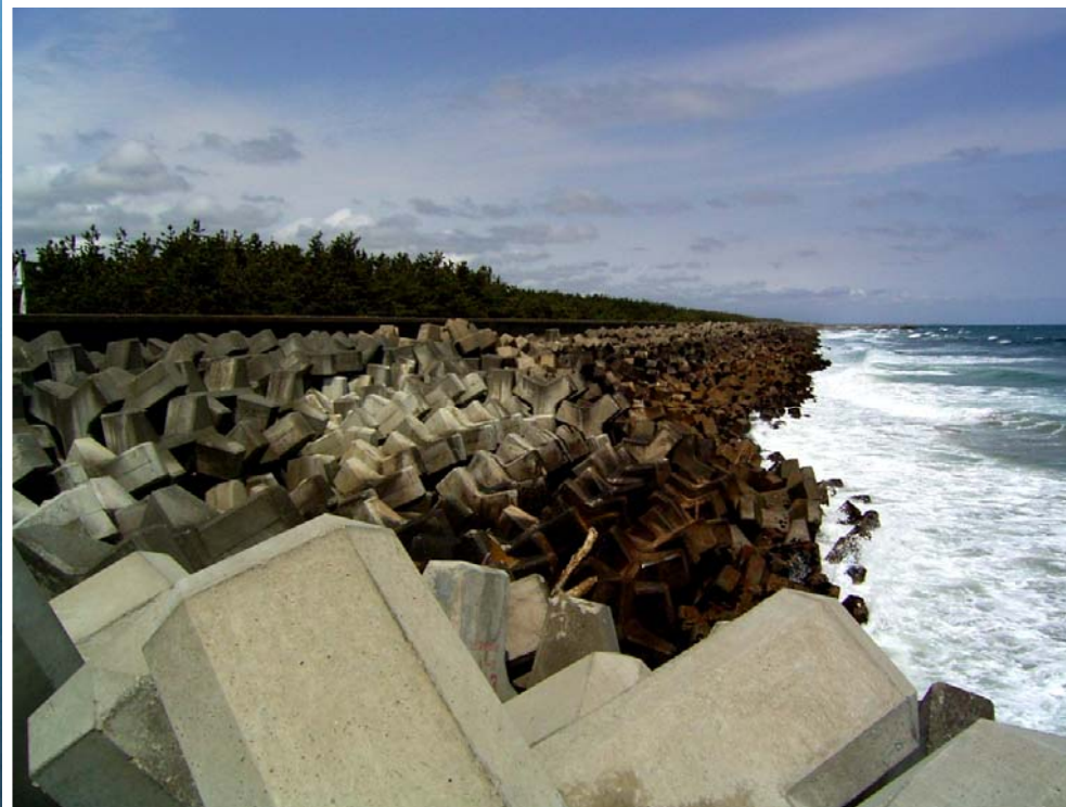
中浜海岸 S4号堤付近 (H17.5.6)
